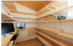
▲ファイルの保存をOA化したサーバールームは、熱がこもらないよう壁の下部に開口を設け、常に涼しい環境をキープ。
