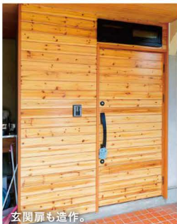
玄関扉も造作。
