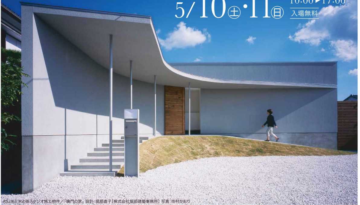
ASJ光と水と街スタジオ施工物件 / 「鳴門の家」設計:堀部直子[株式会社堀部建築事務所] 写真:市村かおり
