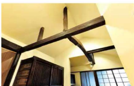
天井裏の梁を出すことで、より広い空間へ。
