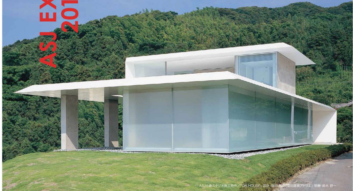
ASJ小倉スタジオ施工物件 / TOR HOUSE 設計: 塚田龍彦(塚田建築デザイン) 写真: 鈴木 研一
